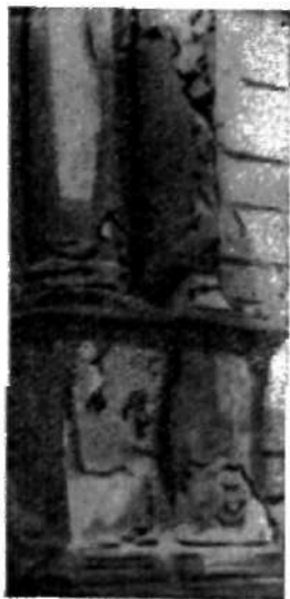
Рис. 107. Выветривание наружных фасадов
