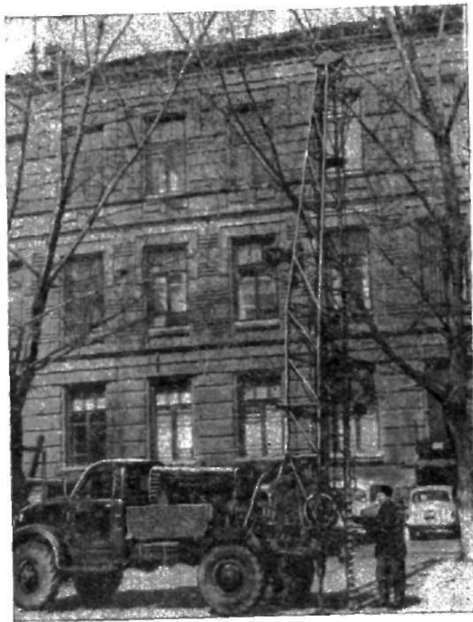
Рис. 204. Буровой станок, смонтированный на машине
